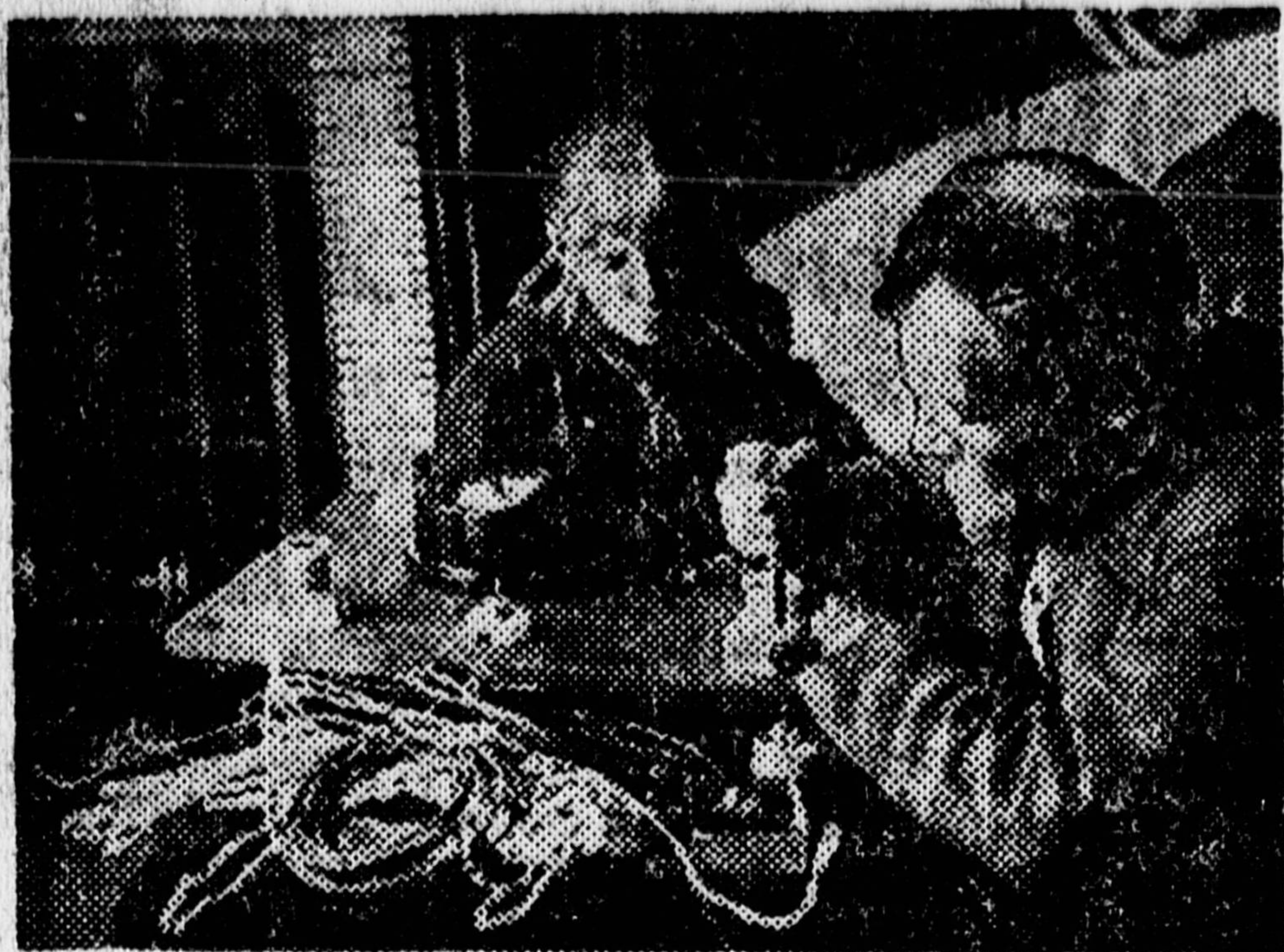
Образцовая школа ФЗД № 3 при вагоно-ремонтном заводе в Вологде организовала свою учебную электростанцию. На снимке: преподаватель физики, товарищ Перфильев, за монтажом распределительного щита.
